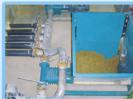
Centrální prostor čerpadla bio-zařízení s vtahovací technikou Powerfeed SSR
